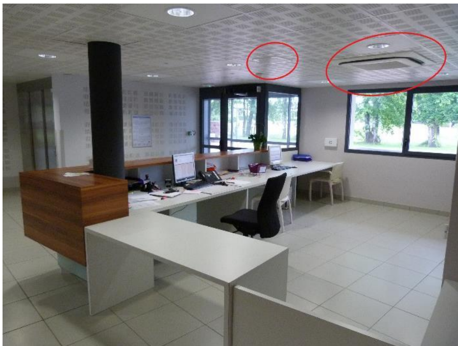
4 - Cassettes de soufflage d'air régulé en température dans un poste d'accueil (climatisation réversible)
