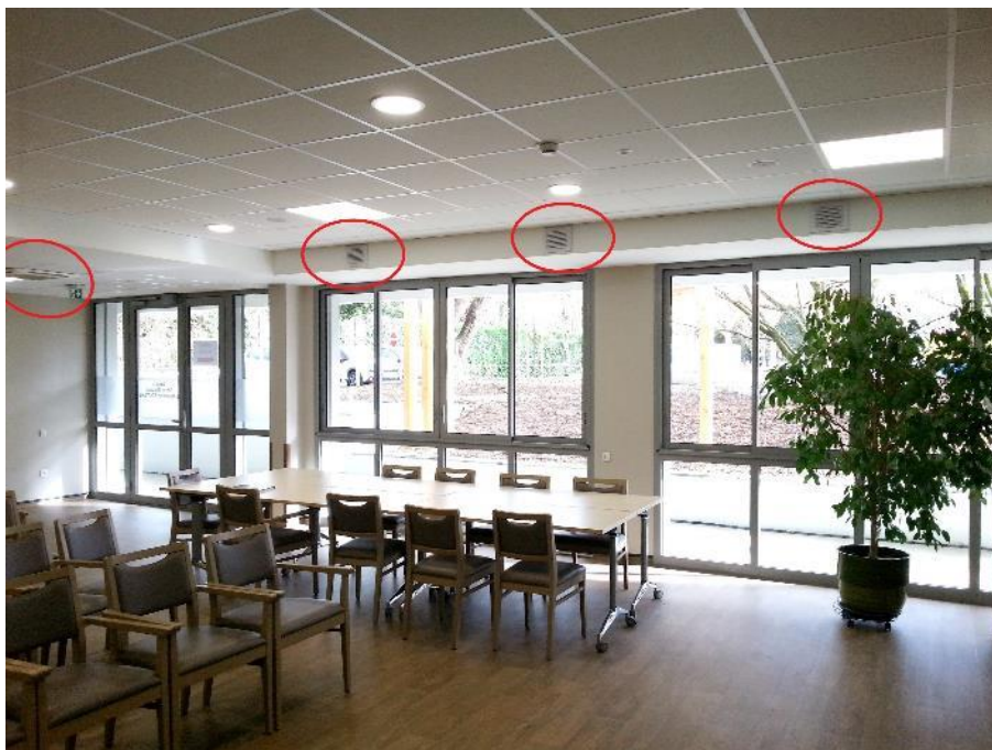
6 - Bouches d'aspiration de l'air vicié dans une salle commune
