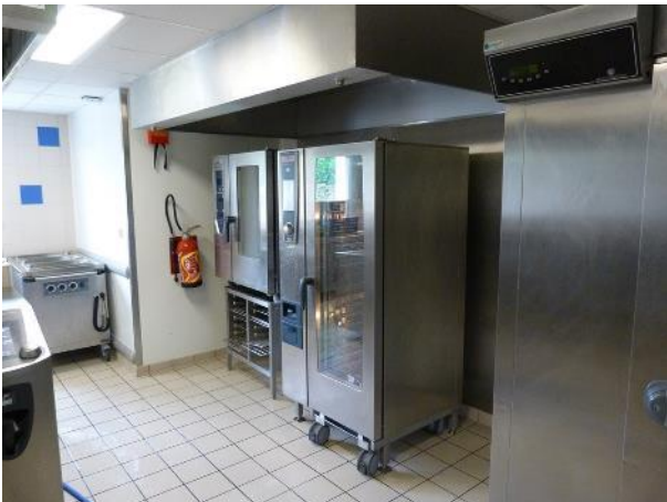
15 - Hotte aspirante simple flux au dessus des fours
