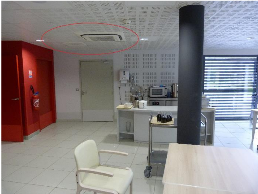
5 - Cassettes de soufflage d'air régulé en température dans un bureau (climatisation réversible)
