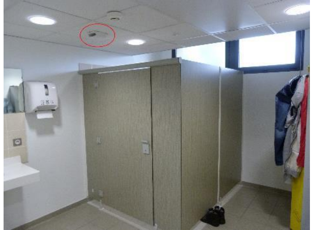
18 - Bouche aspiration VMC dans le local douche d'un vestiaire
