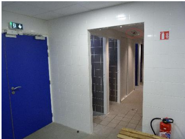
21 - Bouche aspiration VMC dans le local douches collectives d'un vestiaire
