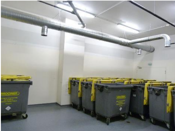
7 - Gaine avec bouches d'aspiration dans un local DASRI
