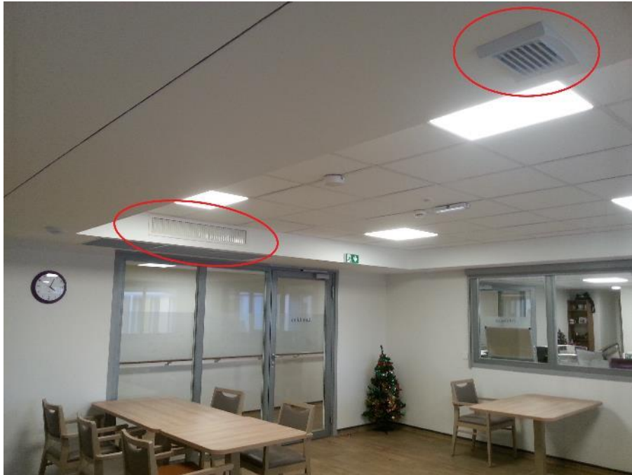
1 - Grille de soufflage d'air régulé en température dans une salle commune et bouche d'aspiration de l'air vicié
