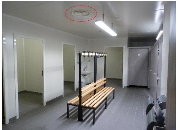
20 - Bouche aspiration VMC dans le local douches collectives d'un vestiaire
