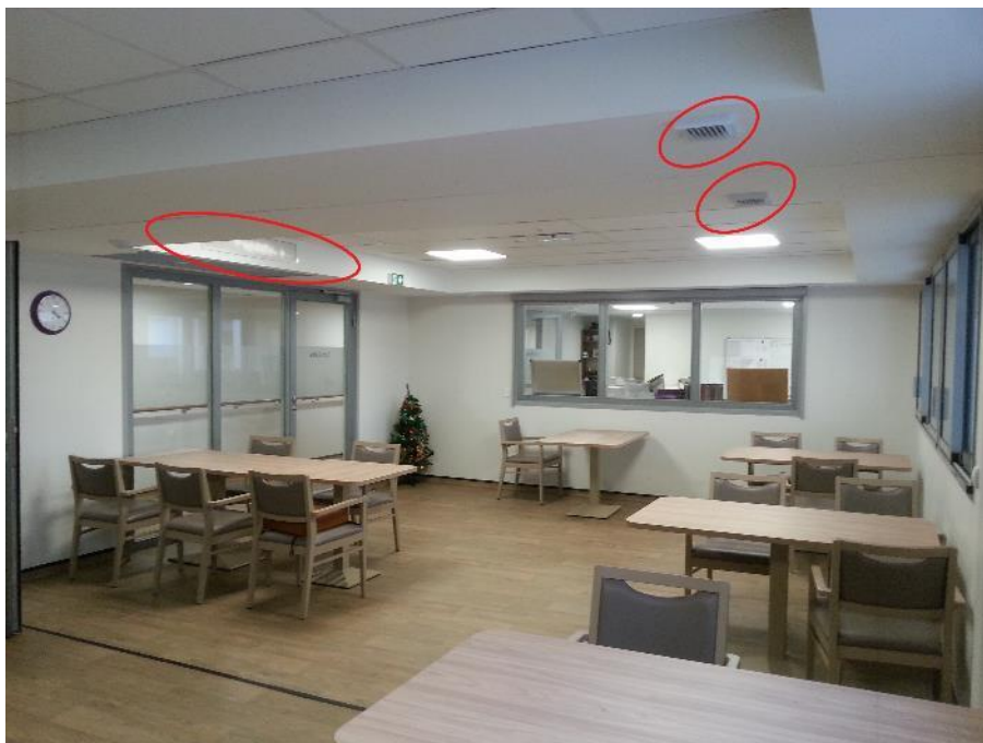
2 - Grille de soufflage d'air régulé en température dans une salle commune et bouche d'aspiration de l'air vicié
