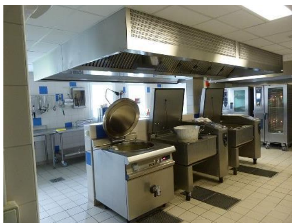
12 - Hotte aspirante à compensation triple flux au dessus du piano de cuisson
