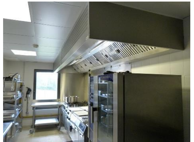
14 - Hotte aspirante à compensation triple flux au dessus du piano de cuisson et du four
