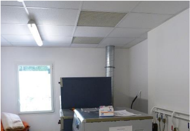
9 - Captage vapeur au dessus de laves-linge (en savoir +)
