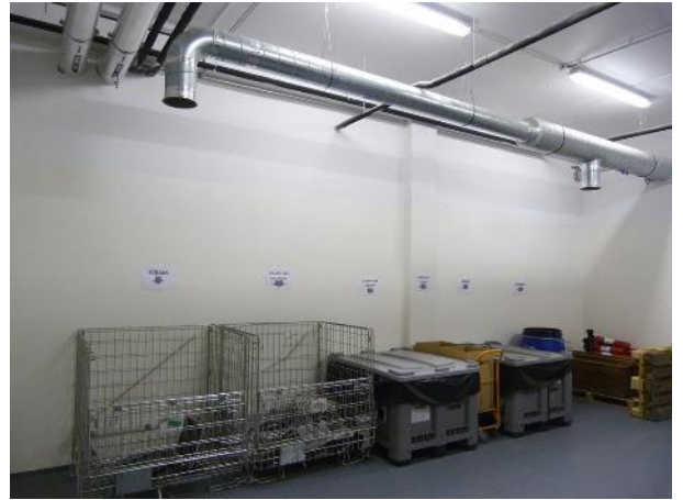
8 - Gaine avec bouches d'aspiration dans un local déchets
