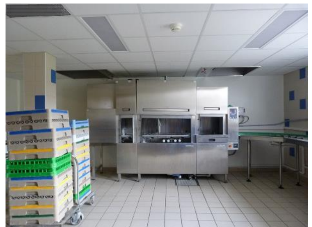
16 - Captage des vapeurs en entrée et sortie d'un lave vaisselles
