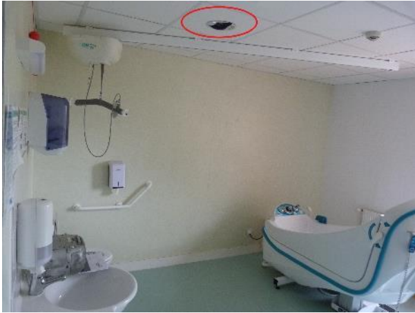
19 - Bouche aspiration VMC dans une salle de bain commune
