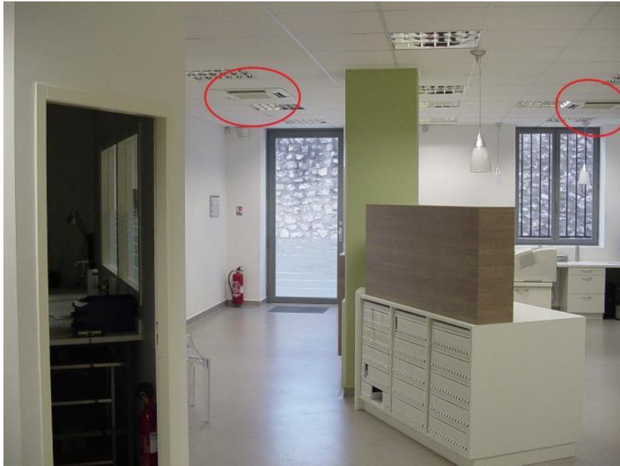
3 - Cassettes de soufflage d'air régulé en température dans un poste d'accueil (climatisation réversible)
