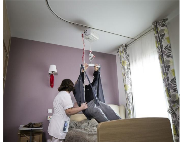
2 - Lève-personne sur rail plafonnier en L avec moteur "fixe" débrochable
