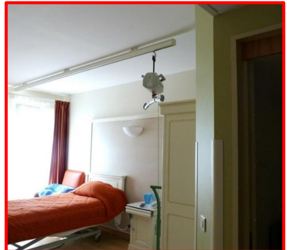
4 - Lève-personne sur rail plafonnier droit avec moteur "nomade"
