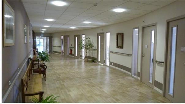
5 - Couloir : Sols lisses (sans joints) pour éviter les bruits de roulements des chariots et faciliter les déplacements (limitation de la résistance au roulement).
