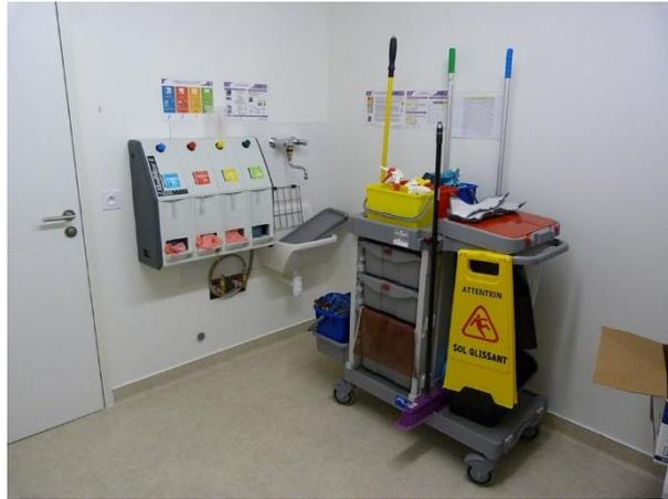
3 - Local ménage avec centrale de dosage et distribution automatique des produits d'entretien (diminution des manipulations et port de charge)
